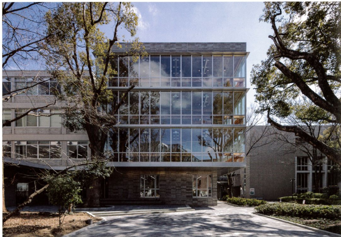
■増築棟の北側ファサード
