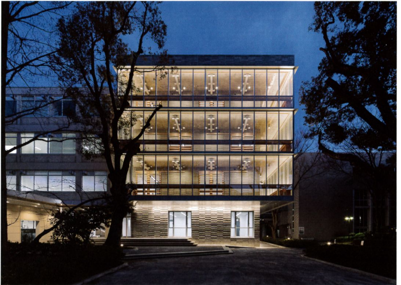
■増築棟の北側ファサード夜景
